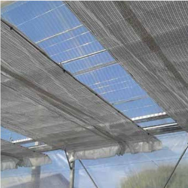
L'impianto in oggetto "schermo" riveste la doppia funzione di telo ombreggiante e di schermo per il contenimento dei consumi energetici, evitando il contatto fra la massa di aria calda interna e l'aria fredda esterna, permette quindi di regolare la massa dell'energia radiante immessa all'interno della serra.
