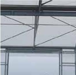
Travetto di supporto gronda centrale per salto di passo - Zincatura a caldo
