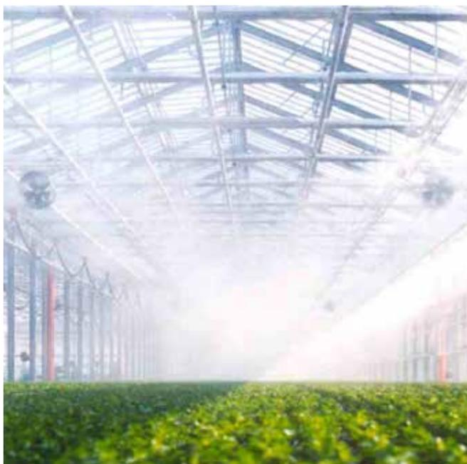
Impianti a pioggia fissi per aspersione in serre con colture nel terreno.
