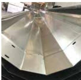
Gronda pressopiegata per la raccolta acqua pluviale - Spessore 15/10 - Sviluppo 557 mm. Zincatura Z450 - Scanso in estremità per sovrapposizione - N. 4 bulloni ogni estremità
