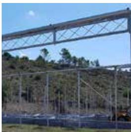
Trave di supporto gronda centrale per salto di passo - Zincatura a freddo - H=500-900 mm
