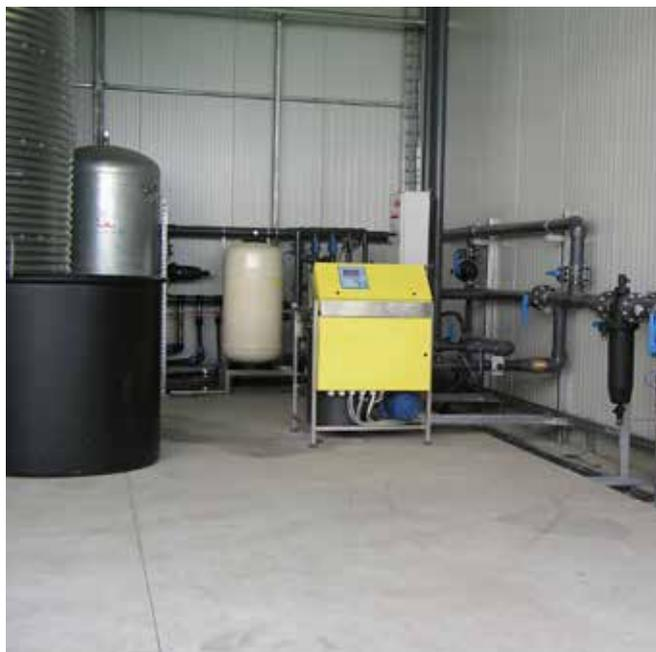
Il sistema di dosaggio in mixing tank, oltre a garantire una perfetta miscelazione tra i fertilizzanti, gli acidi e l'acqua di irrigazione, rende il dosaggio preciso e stabile anche al variare delle portate irrigue.
