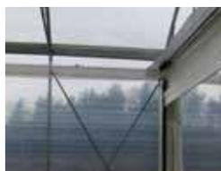
Lamiera a L da posizionare in doppio profilo alle estremità delle aperture rollbar
