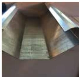
Gronda pressopiegata per la raccolta acqua pluviale - Spessore 12/10 - Zincatura sendzimir Z 275
